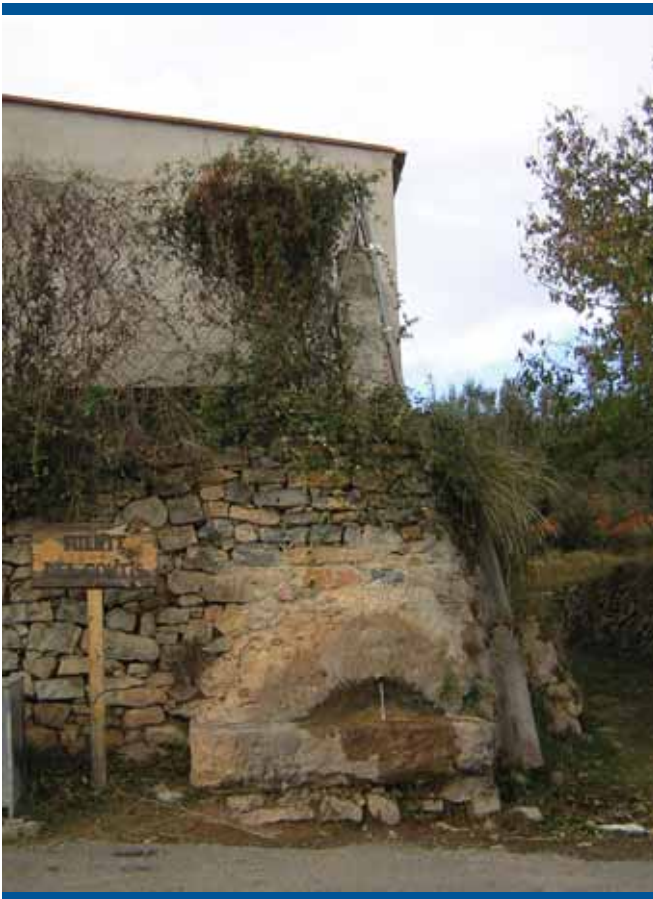
Fuente y abrevadero de Contis (Teresa)
